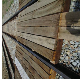
Obr. 4 - Provizorní přechod přes koleje - dřevěný
