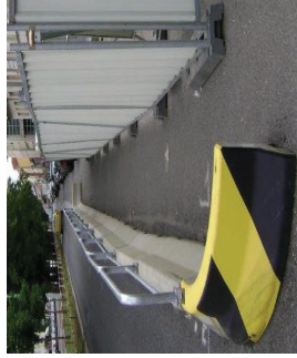
Obr. 10 - Vymezení od silniční dopravy svodidly (betonové/plastové s vodou), patky oplocení nezasahující do provizorní komunikace pro pěší
