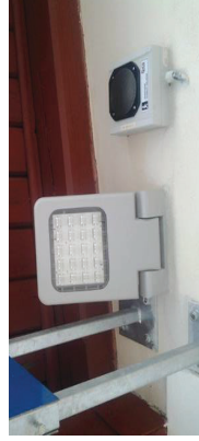
Obr. 13 - Příklad LED svítidla vhodného venkovního prostředí
