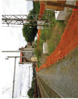
Obr. 9 - Zábrana formou sítě k vymezení směru dočasných komunikací
