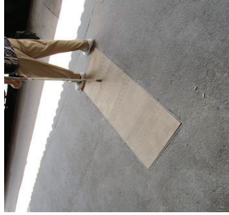
Obr. 6 - Poklopy na nástupišťích a komunikacích – provizorní
